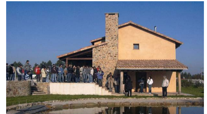
Vivienda bioconstruida, con Sistema de Depuración de Aguas mediante Sistemas Ecológicos (lagunaje)
